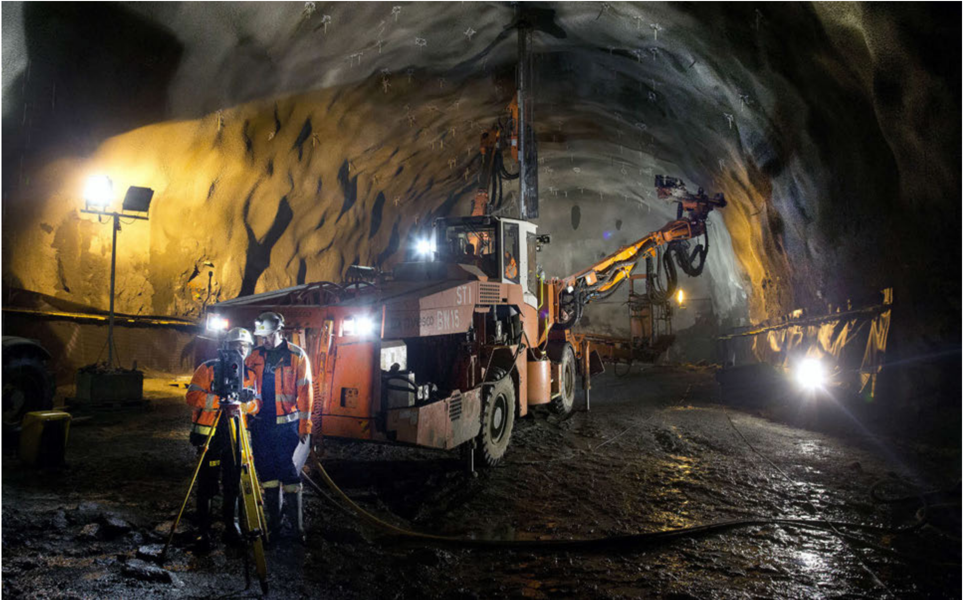
Borað fyrir boltum til bergstyrkingar í stöðvarhúshvelfingunni, 286 metra inni í fjallinu Samsstaðaklifi, við framkvæmdir við stækkun Búrfellsvirkjunar. Sjá síðu 16 FRÉTTABLAÐIÐ/STEFÁN.
