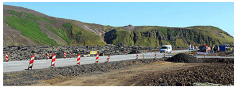
Framkvæmdir við gatnamót Norðurljósavegar og Grindavíkurvegar. MYND/SIGGEIR F.ÆVARSSON
