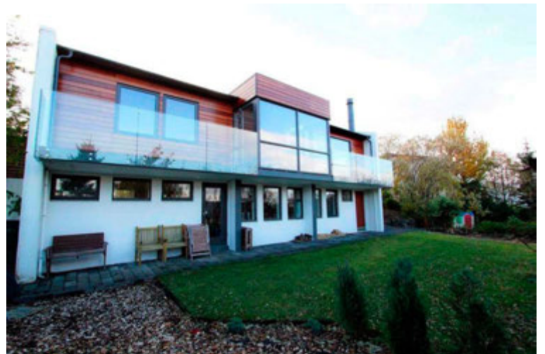
Húsið hefur nær allt verið endurnýjað á síðastliðnum árum.
