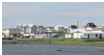
PÓRSHÖFN Nýr leikskóli er í byggingu.
