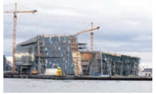
HARPA Taka þarf niður stálvirkið á suðurhlíð hússins sem snýr að Seðlabankanum. Nýtt stálvirki kemur til landsins í desember. FRÉTTABLAÐIÐ/VALLI
