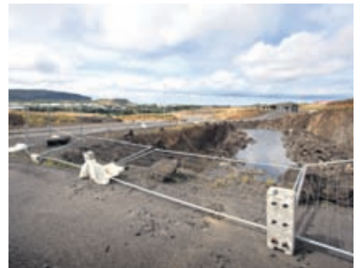
SKURÐUR VIÐ VEGINN Um sex metra djúpur skurður liggur upp við veg og hringtorg. Girðing liggur við jörðu. MYND/ARNÞÓR
